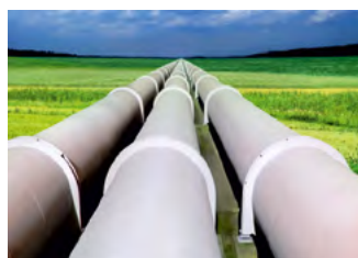
Energia Hidráulica e Pneumática
